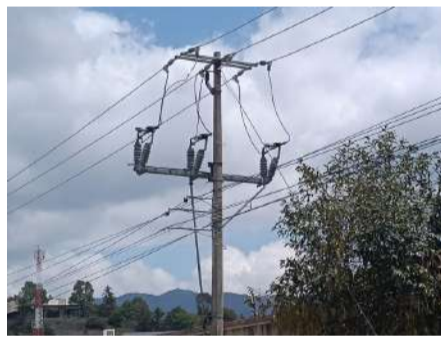
Instalan transformador recién comprado
