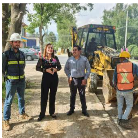
La obra abarcará cerca de dos kilómetros
