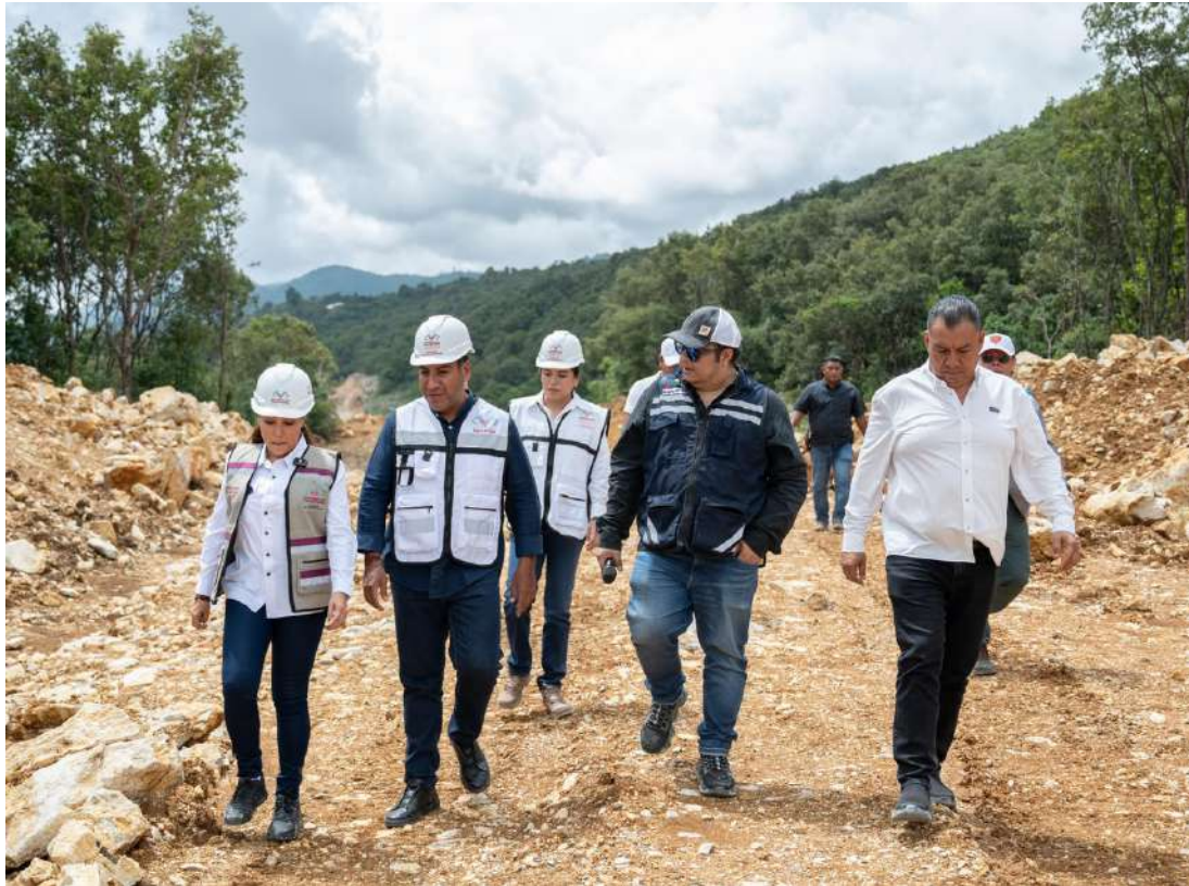
Trabajos incorporan medidas ambientales mediante el aprovechamiento de materiales extraídos
