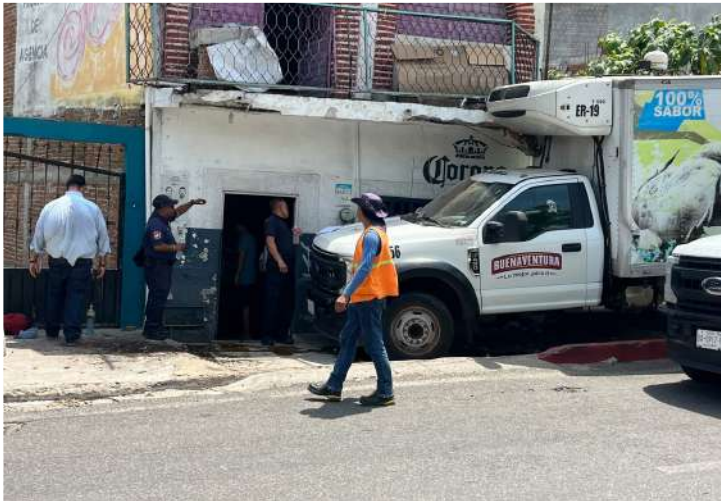
El impacto destruyó parte de la fachada
