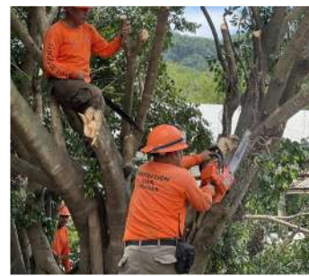
Retiran lodo, tierra y ramas para evitar mayores afectaciones
